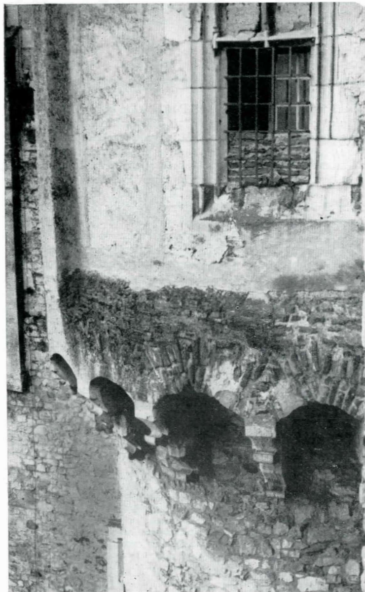
Fig. 7. „Guri de păcură“ (mâchicoulis) pe console, la Turnul lui Capistrano (colțul sud-vestic al castelului).
