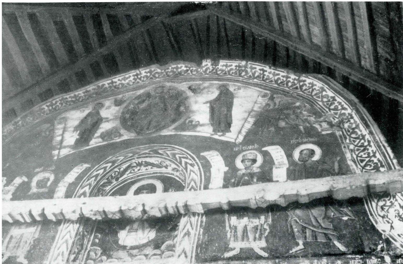
g. 4. Grindă tirant înainte de restaurare.
